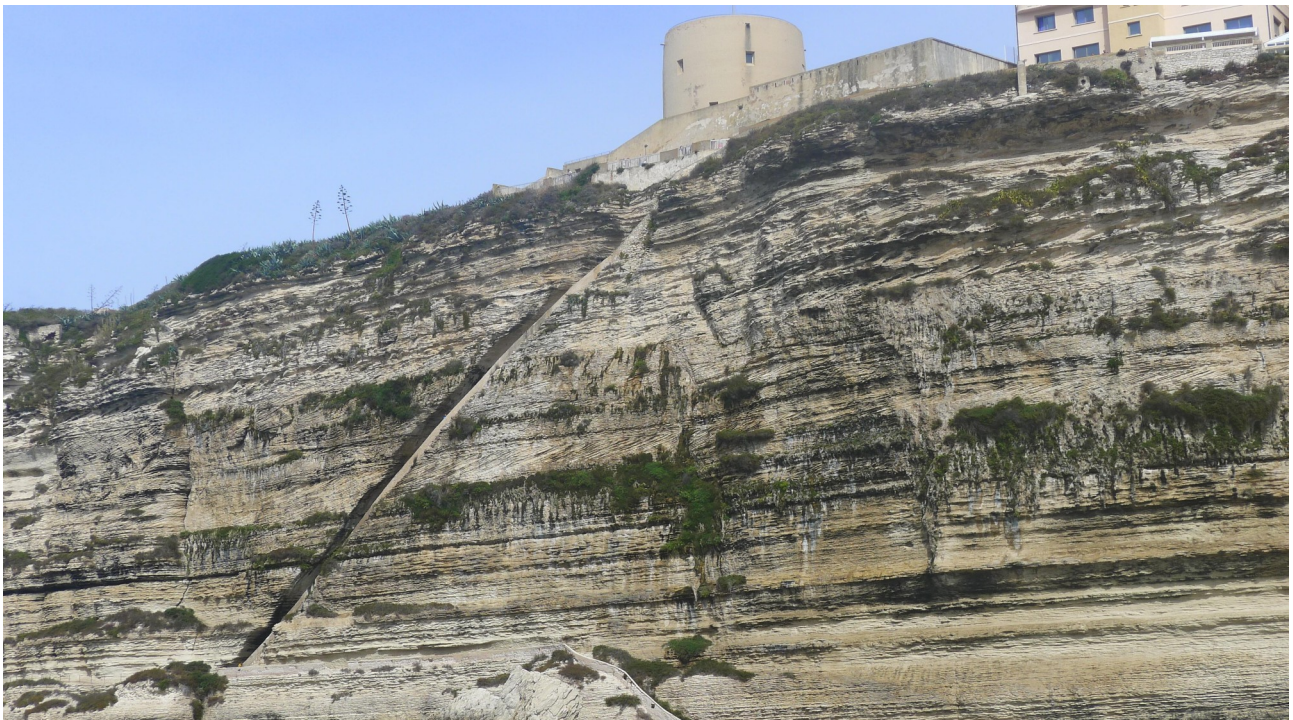
L'escalier du roi d'Aragon
